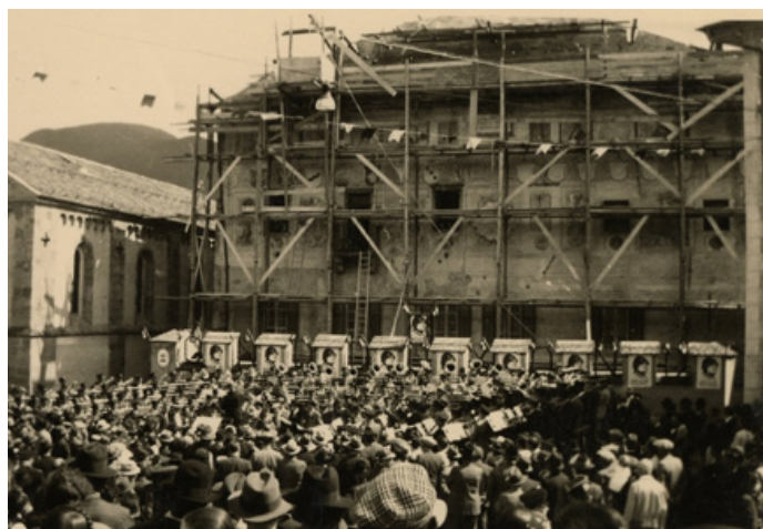
AMCF, Il Palazzo nel 1937 con i ponteggi per il restauro della facciata e la ricostruzione del timpano.
